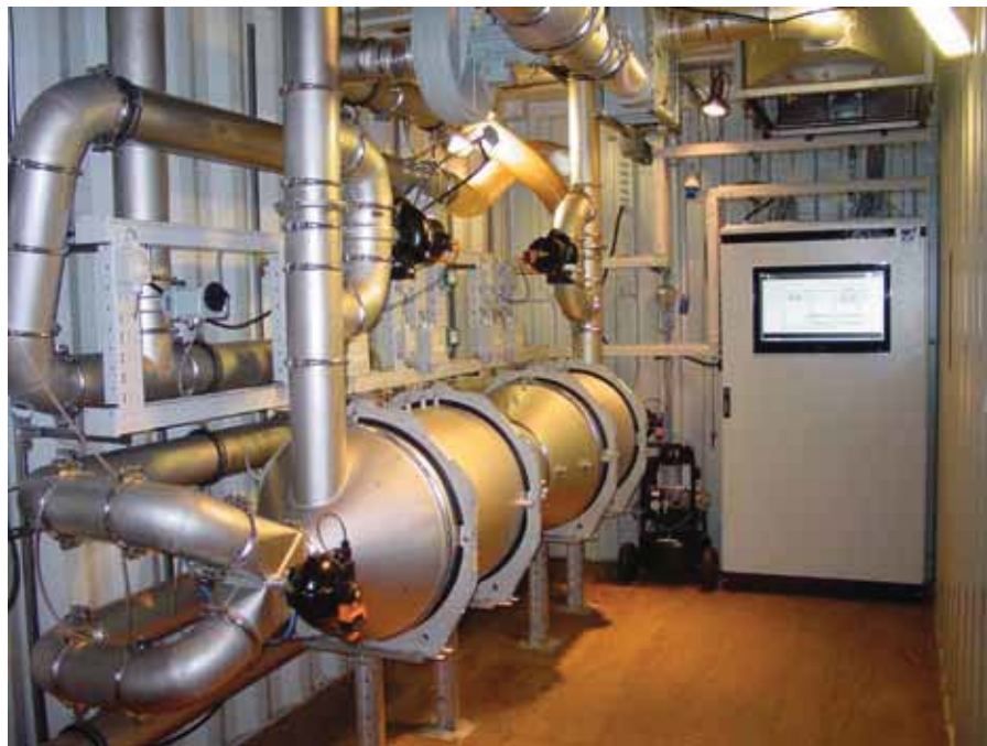
CLMO system i container set mod eltavle. Foto: AKTOR
